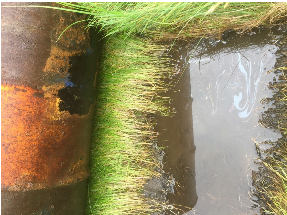
Figur 3. Forurensing av olje/diesel ved Bugøynes avfallsplass.
