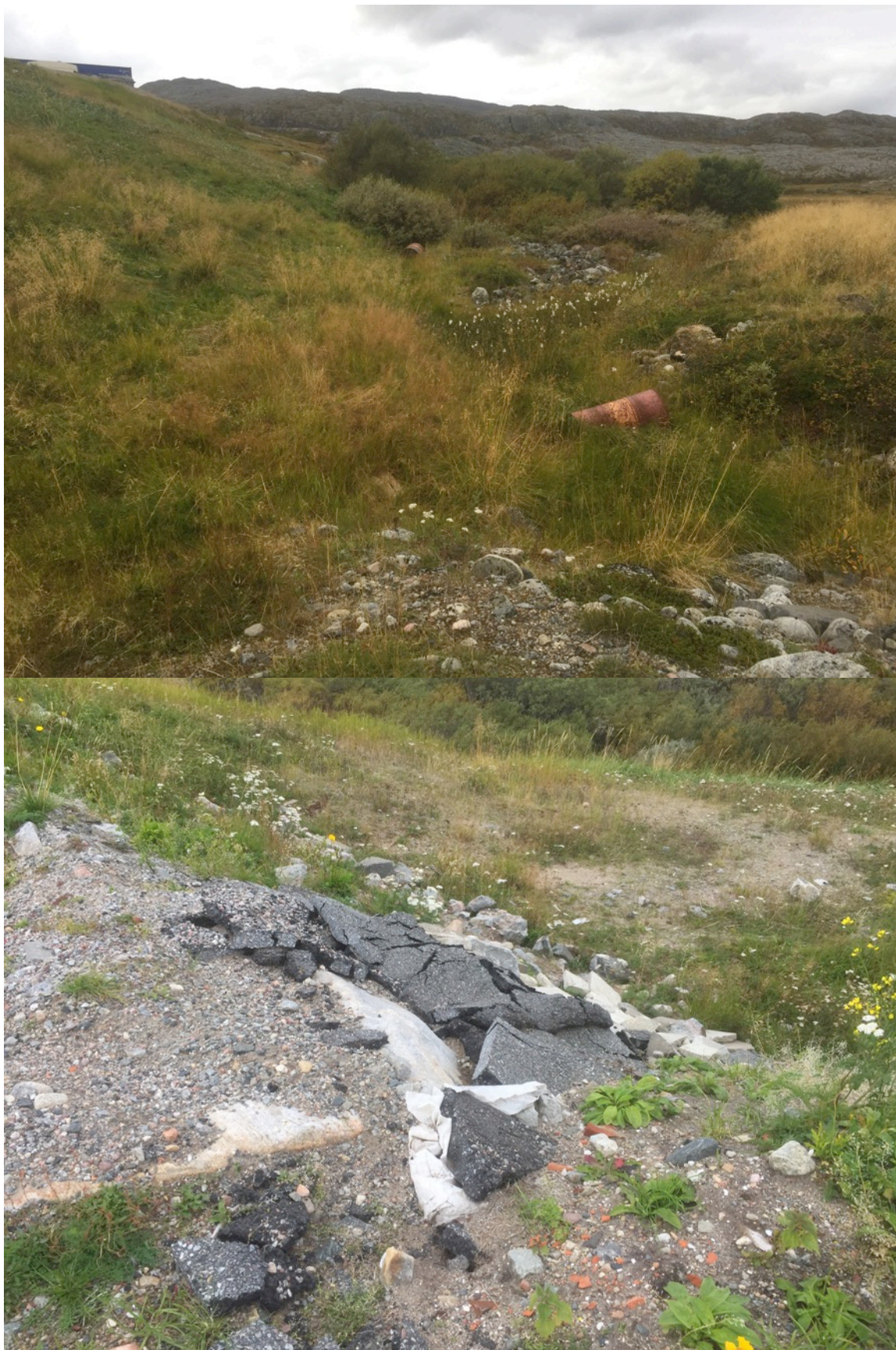
Figur 4. Påvist oljeforurensning ved Bugøynes avfallsplass. Sannsynlig lekkasje fra gamle oljefat og asfalt.
