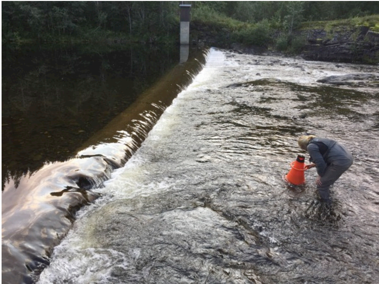
Figur 11. Lokaltet 155-38779 – Røssåga ved Sjøforsen. Prøver samlet inn nedstrøms terskel. Oversiden terskel domineres av langt stilleflytende parti.
